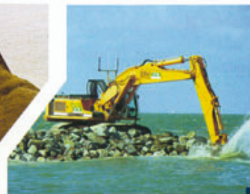
Réglage des couches d'enrochements à l'aide de la pelle 964 équipée d'un GPS.
